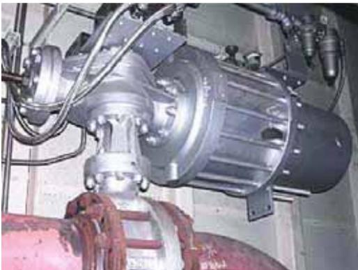
潤滑油温度制御弁 潤滑油圧力制御弁
