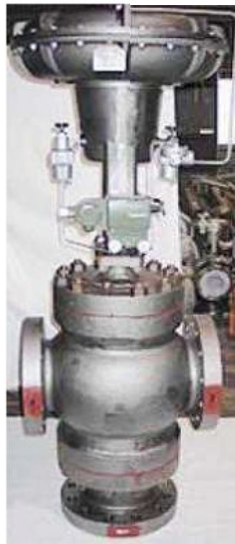
燃料ガス温度制御弁
